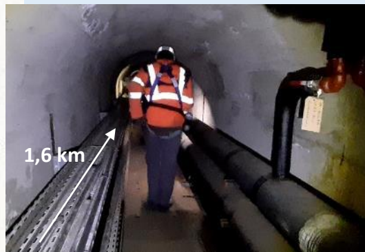
← Galerie technique multi-réseaux d'Angers – ZUP Roseraie (1967)
